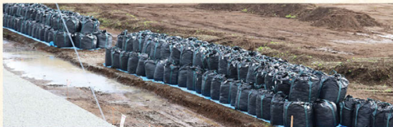
除染作業で集められた土砂やがれきの入ったフレキシブルコンテナバッグの山
