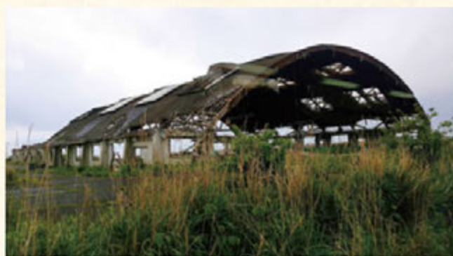
津波被害に遭い破壊された建物が撤去されずに残された姿
